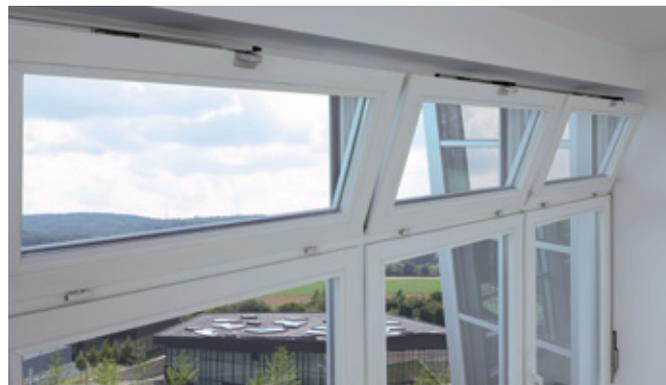
Manuelle oder motorische Betätigung zur Lüftung
